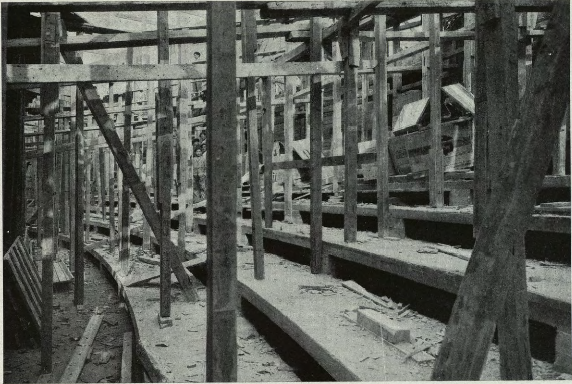
Anfiteatros. Gradas de hormigón.
