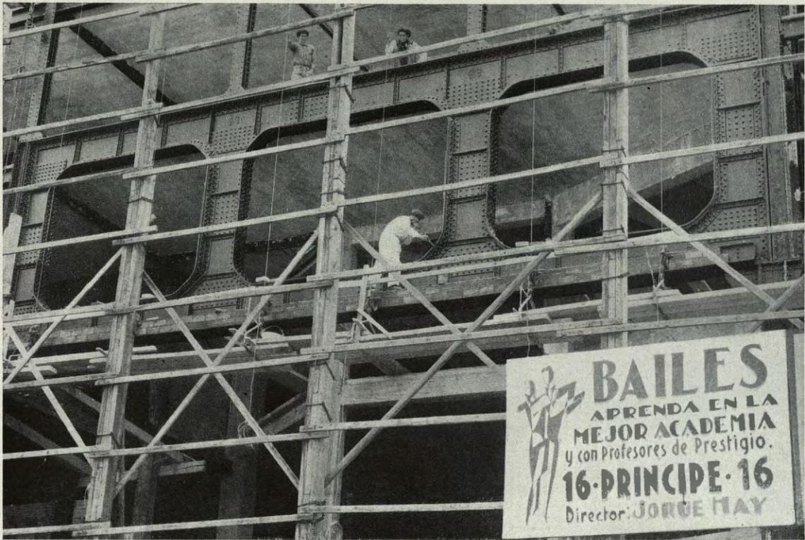
Montaje de la viga Vierendell de la entrada del Cine.
